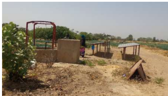
Fournir de l'eau à un périmètre d'irrigation par une pompe alimentée par l'énergie solaire PARERBA, Enabel, Sénégal
