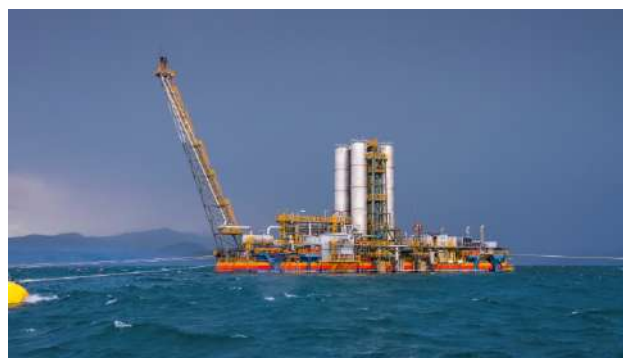
Plateforme d'extraction de méthane sur le Lac Kivu (Projet KivuWatt, BIO, Rwanda)
