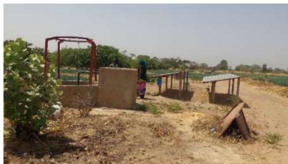
Watervoorziening van een irrigatiegebied via pompen op zonne-energie PARERBA-project, Enabel, Senegal
